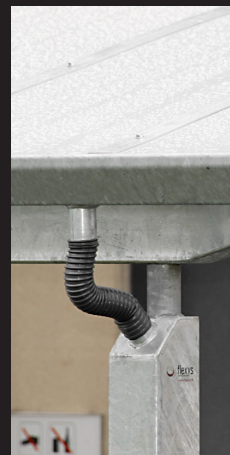
Afvanding via integreret nedløb i bærende søjler
